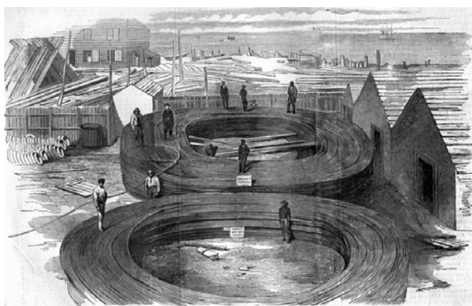
Рис. 4. Бухты кабеля, предназначенного для укладки на магистраль Дувр — Остенд [6]
